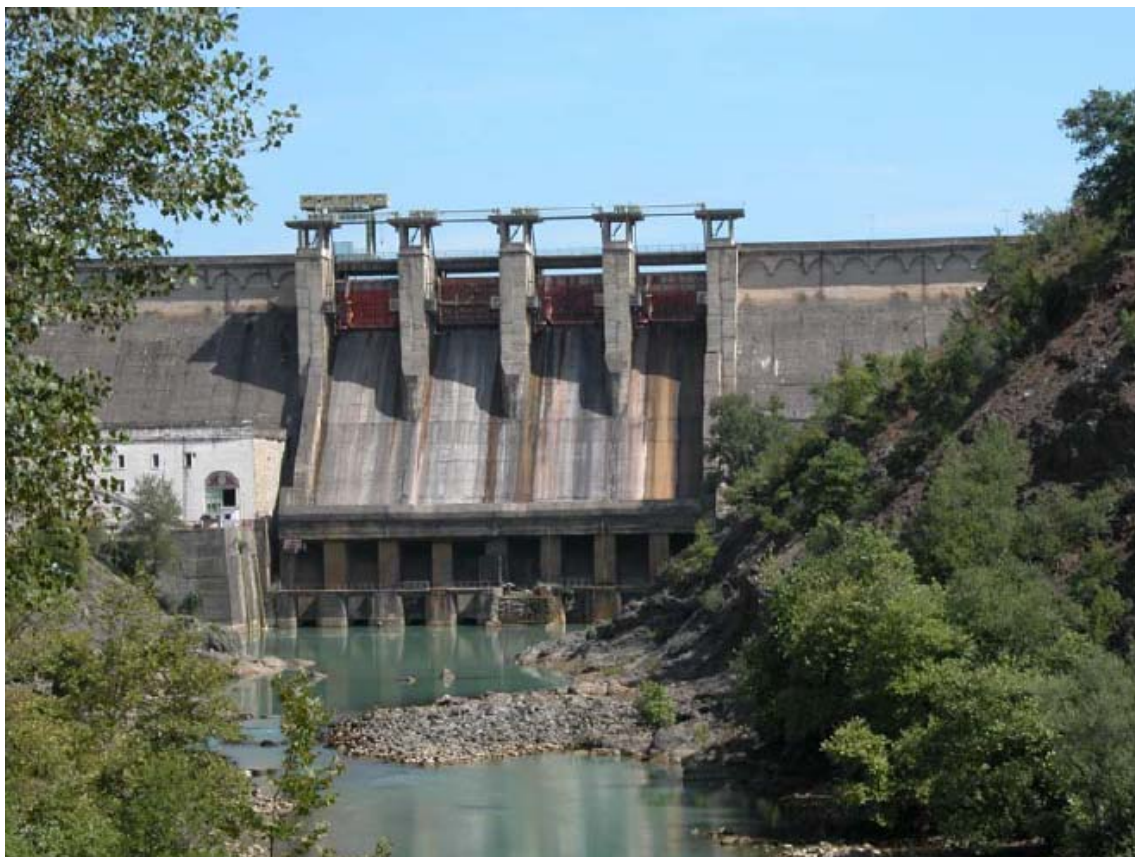
Figura 3 Diga gravitative prej betoni e Ulzës
